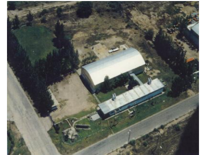
Vista Aérea Planta
